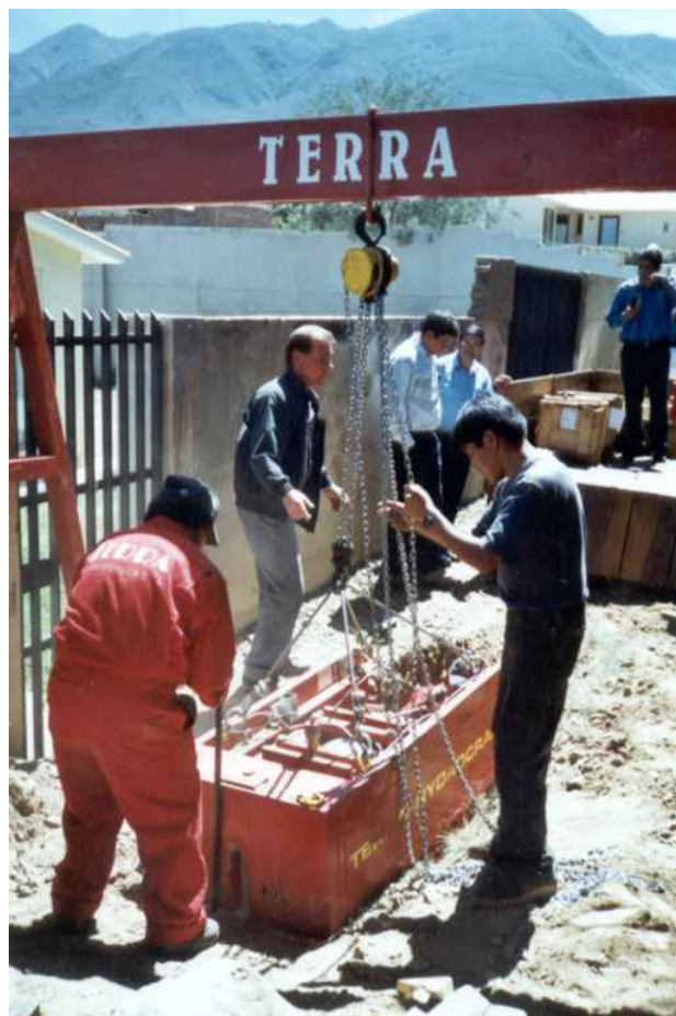
Image en haut à gauche: L'HYDROCRACK / version courte est descendu dans la fouille.
