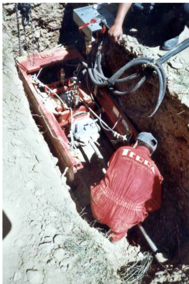
Image en haut à droite: Les tiges ont été introduites en 1,5 heure dans l'ancienne conduite de 100 mètres de long
