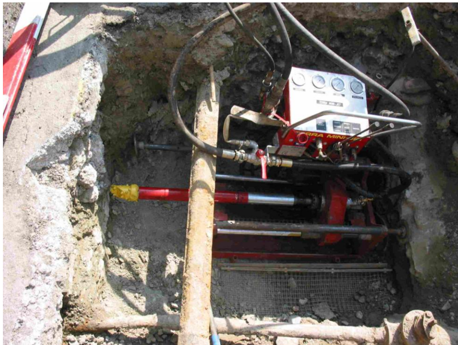
Ci-dessus: la MINI-JET TERRA avec la tête frappante à air comprimé TERRA-ROCK ø 65 mm. Au démarrage, on utilise l'adaptateur spécial à la place du support de sonde.
