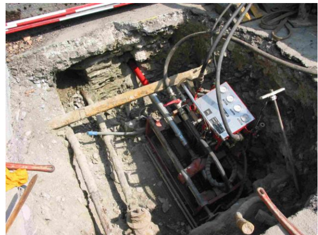
Droite: La tête frappante à air comprimé TERRA-ROCK ø 65 mm au départ, avec le support de sonde.
