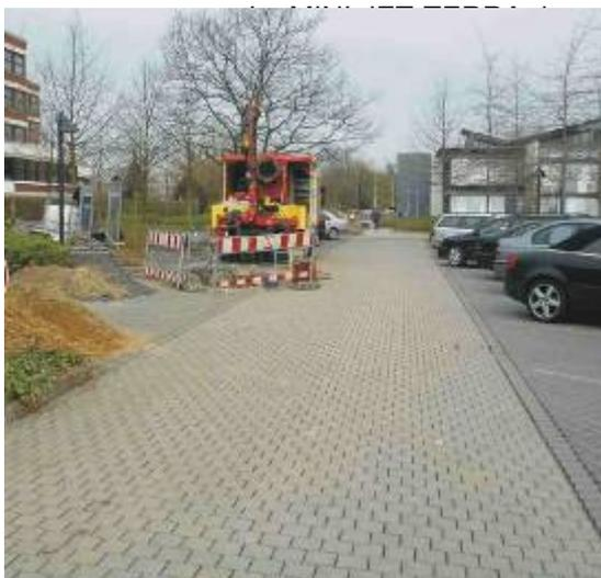
La vue sur la fouille de départ montre le trottoir en pavés sous lequel les fourreaux PEHD ø 225 mm doivent être posés.
