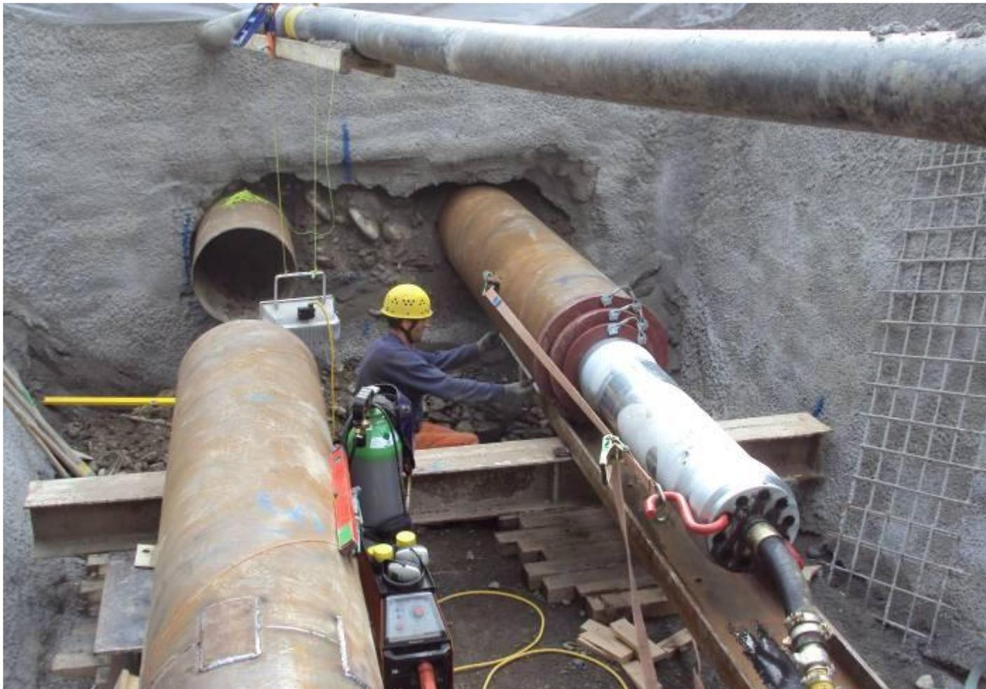
A Wimmis, dans l'Oberland Bernois, il fallait poser deux tubes acier de  $\varnothing$  600 mm sur une longueur de 17 mètres sous la ligne de chemin de fer à voie unique. Dans ces tubes ont ensuite été posés des tuyaux de transport de chauffage urbain. Basée à Adelboden et à Oey la Société de construction Burn & Künzi a décidé de mettre en œuvre pour ce projet, son marteau pousse-tube TERRA TR 360 acquis tout récemment.
