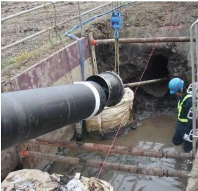
Le canal de forage est agrandi jusqu'au  $\varnothing$  800 mm. Le tuyau PEHD  $\varnothing$  560 mm peut maintenant être introduit.
