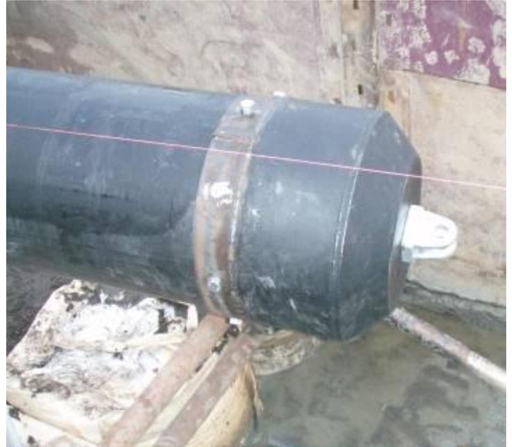
Le mandrin de traction est mis en place sur le tuyau PEHD 560 mm.
