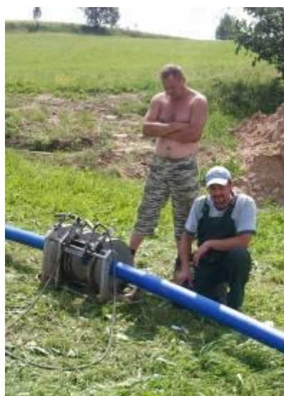
Les tuyaux PEHD DE 110 mm sont soudés au miroir.
