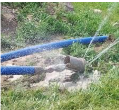
L'alésage commence. La Bentonite gicle par les buses de l'aléreur.
