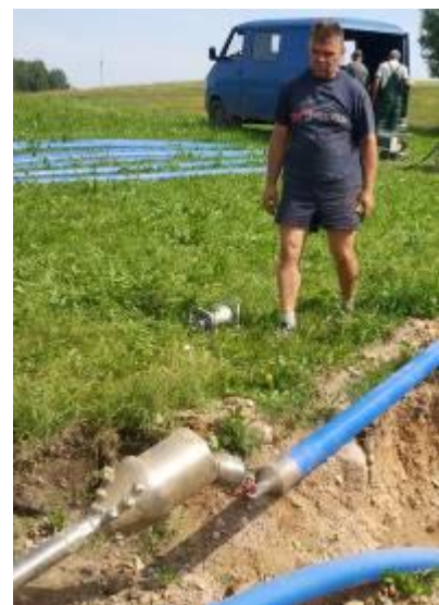
L'aléreur \varnothing 260 mm relié au fourreau PEHD DE 110 mm de 130 mètres de long.
