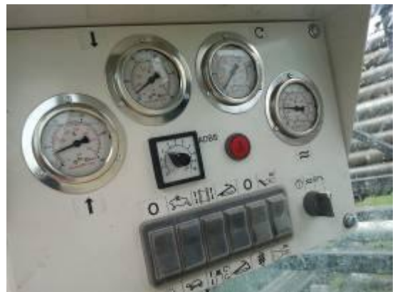
Vue sur la station de contrôle de la TJ 5415 S
