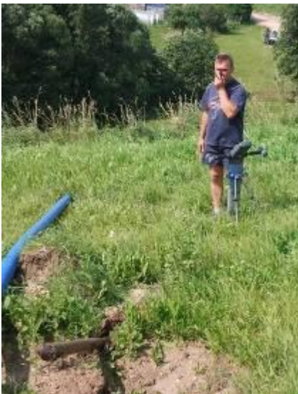
La tête de forage atteint l'objectif exactement dans l'alignement de la nouvelle conduite d'eau.
