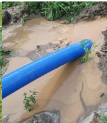
Le fourreau PEHD est introduit. Le fluide de forage s'écoule en continu hors du canal de forage.
