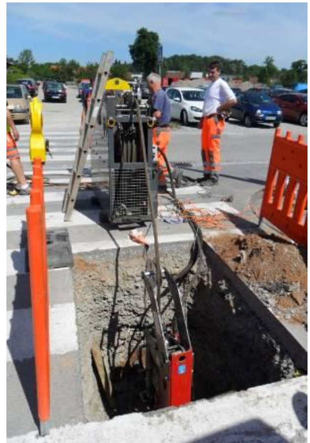
L'enrouleur de câble automatique X 400 enroule le câble de traction en synchronisation avec l'introduction du fourreau.
