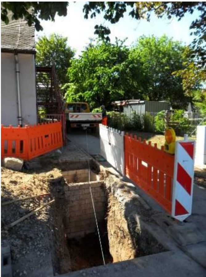
Le câble de traction est introduit dans l'ancienne conduite à l'aide d'une camionnette.
