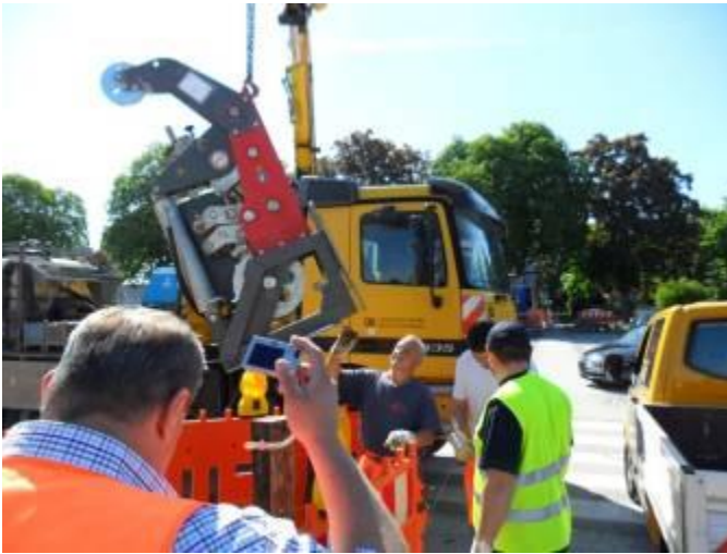
Le TERRA-EXTRACTOR X 400 est déchargé et descendu dans la fouille machine.
