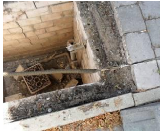
Le câble de traction est tiré à l'aide d'une chaussette de traction.
