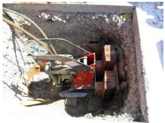
L'éclateur à câble X 400 dans la fouille machine.
