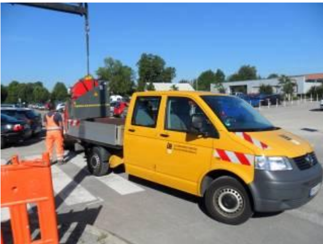
L'enrouleur de câble est déchargé et mis en place.
