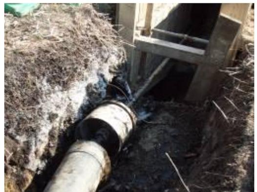
Le tuyau PEHD de DE 355 mm est monté sur l'alésieur de 520 mm.
