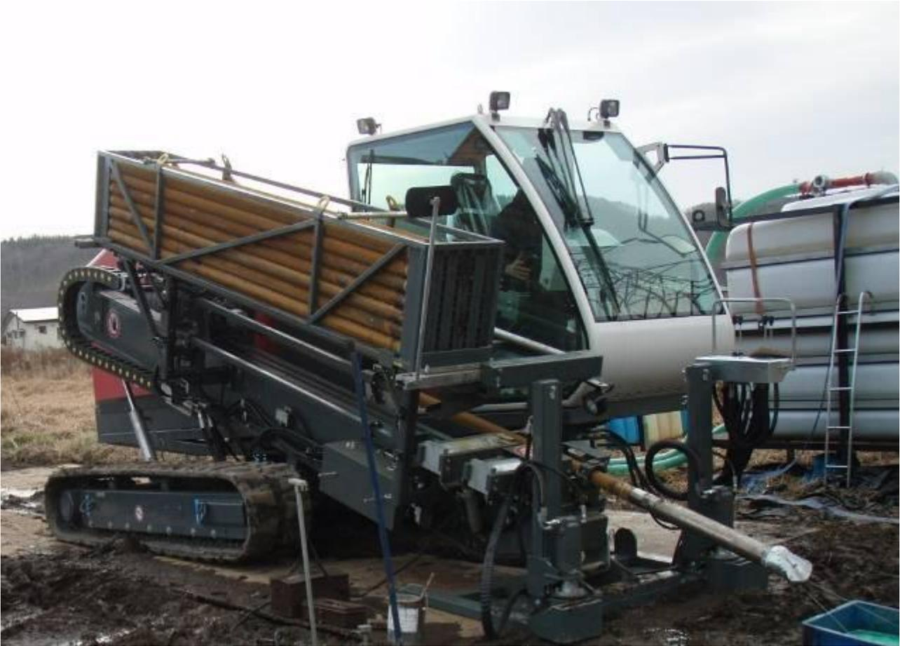
Un fourreau PEHD DE 355 mm devait être posé en forage dirigé sur une longueur de 170 mètres dans une forêt vallonnée avec une différence de hauteur de 23 mètres. La profondeur maximum du forage était de 14 mètres.
