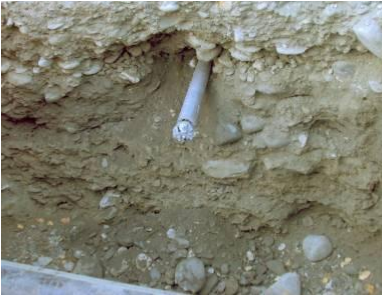
La tête frappante à air comprimé atteint la fouille d'arrivée.
