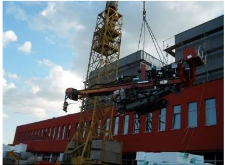
Pour le premier forage, on a commencé à huit heures du matin par l'installation de la TERRA-DRILL. Peu après, le travail pouvait débuter. Le forage de 125 m de profondeur s'est fait dans de la roche dure, puis dans un sol plus tendre en profondeur, à une vitesse de 12-18 m à l'heure. Comme la roche commençait déjà à partir de 2 m, il n'a fallu enfoncer des fourreaux de protection DE 178 mm que sur 3 m.
