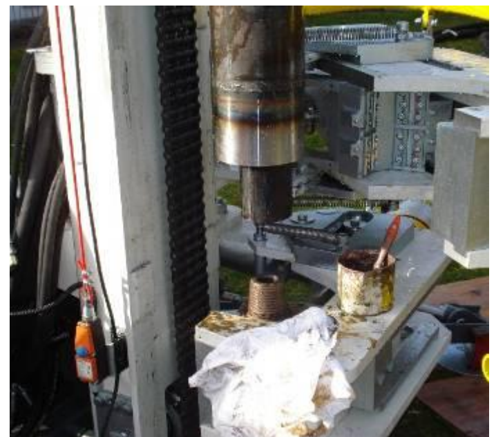
La tige intérieure et le tubage de protection sont vissés.
