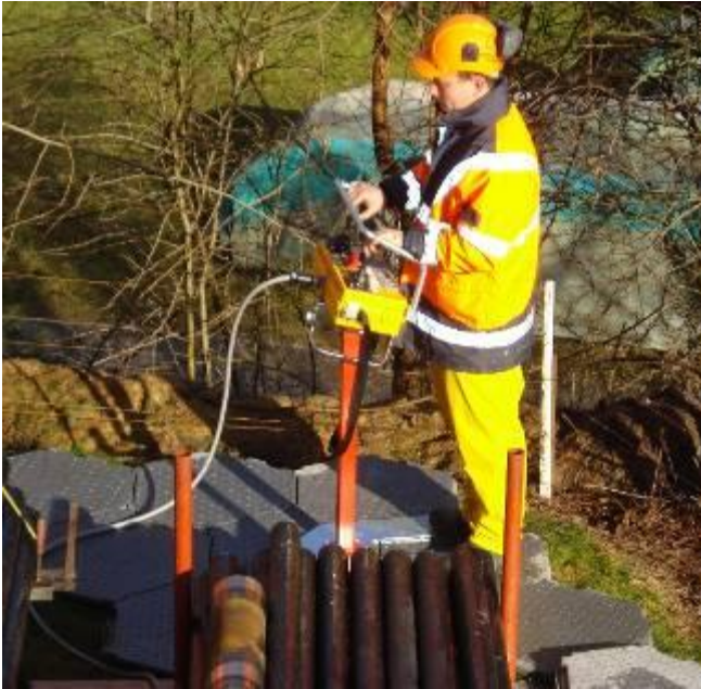
La foreuse se manipule avec la télécommande, ce qui permet à l'opérateur d'avoir une position optimale et une vue dégagée.
