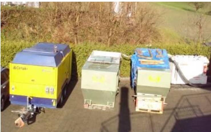
Le compresseur d'air, deux bennes pour la boue de forage ainsi que le groupe d'entraînement pour la TERRA-DRILL 150x7 V sont positionnés à l'extérieur du site de forage.
