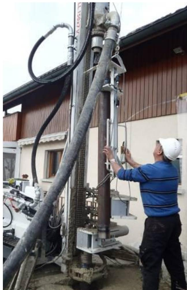
Une nouvelle connexion fourreau de protection avec tige incorporée est positionnée avec le dispositif de manutention, et serrée hydrauliquement.
