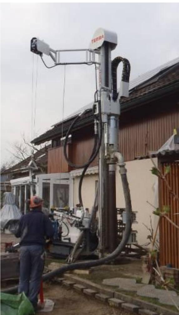
Sur les 46 premiers mètres, les fourreaux de protection DE 152 mm et les tiges de forage DE 89 mm ont été enfoncés en même temps avec le marteau fond de trou.
