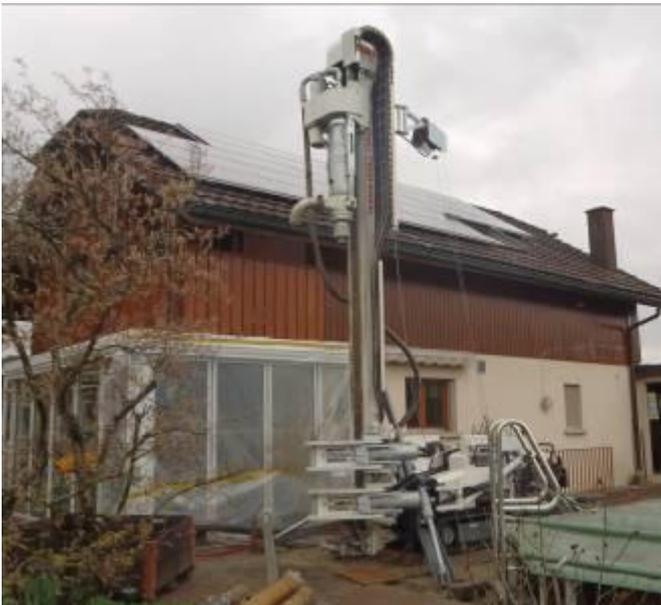
Le deuxième forage est descendu à une profondeur de 120 m à une distance de 6 m.
