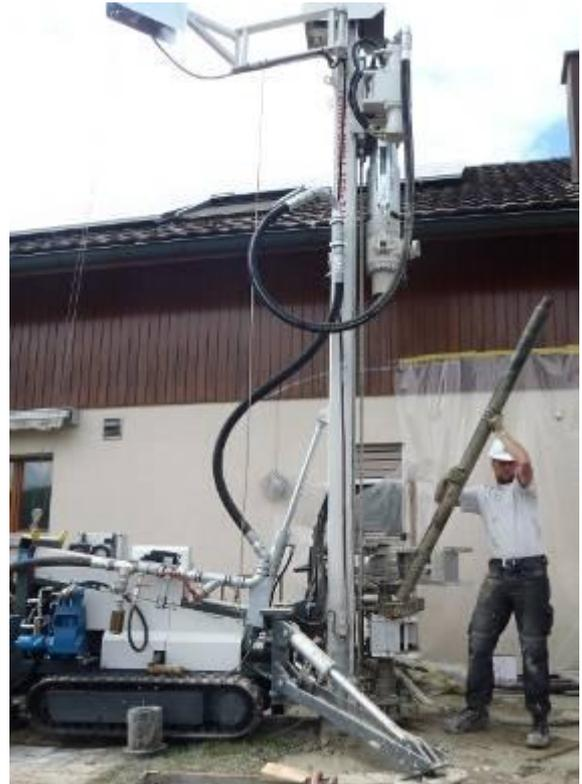
Lorsque le marteau fond de trou a atteint la profondeur de 100 m, les tiges de forage et le marteau sont démontés.
