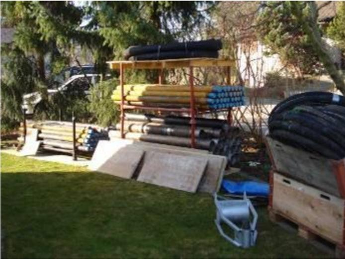
Les tiges de 2 mètres DE 89 mm et les fourreaux de protection 152 mm sont stockés dans la cour de devant.
