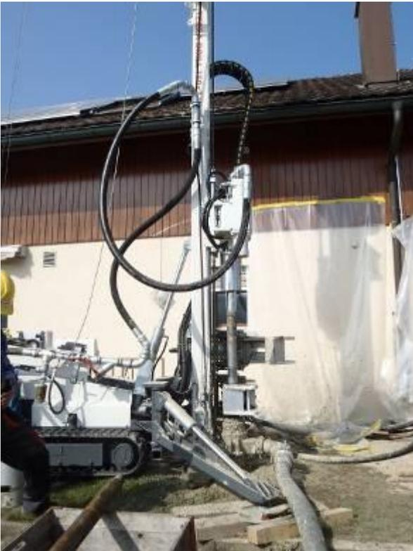
Les fourreaux de protection sont descendus jusqu'à 46 m. Maintenant le marteau fond de trou fore seul avec les tiges de forage jusqu'à la profondeur maximale choisie.
