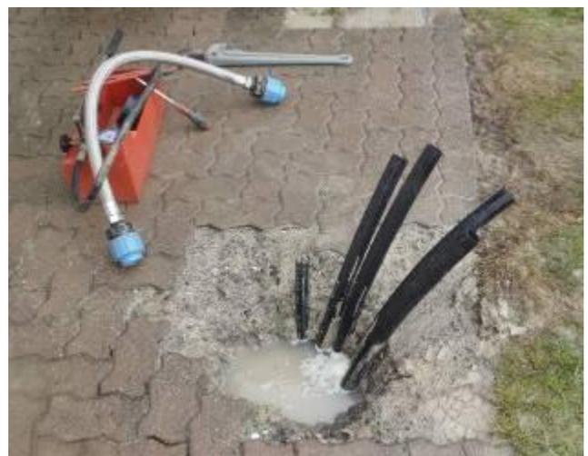
L'une des deux sondes (double sonde en U DE 40 mm avec tuyau de remplissage 25 mm) après le remplissage du trou de forage.
