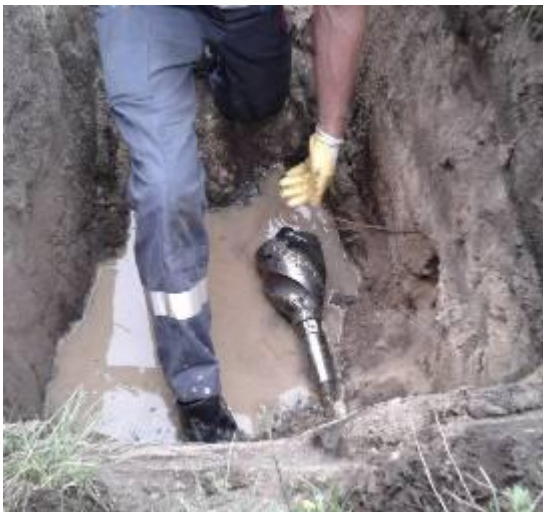
L'aléreur DE 160 mm est monté. L'introduction du fourreau peut commencer.
