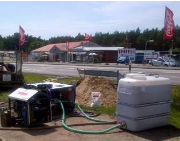
Le groupe hydraulique avec la station de mélange et d'injection et la cuve de 1'100 litres sont positionnés à côté de la fouille de travail.
