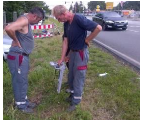
La tête de forage est repérée avec exactitude tout au long du forage du trou pilote.
