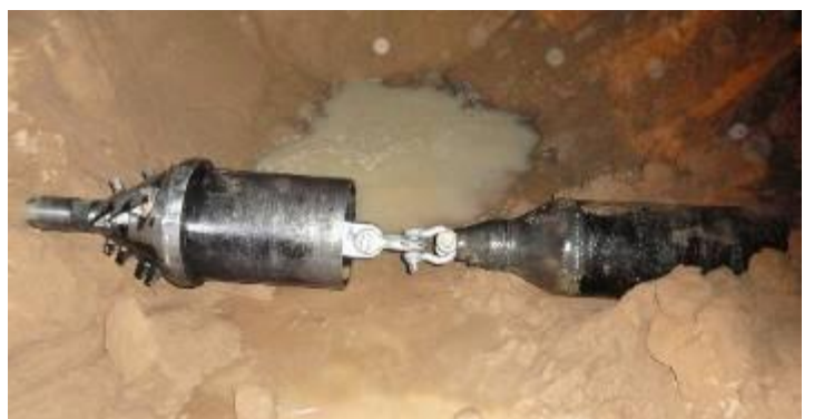
Le tube acier DE 324 mm arrive de l'autre côté de la route après une introduction d'une longueur totale de 65 mètres.
