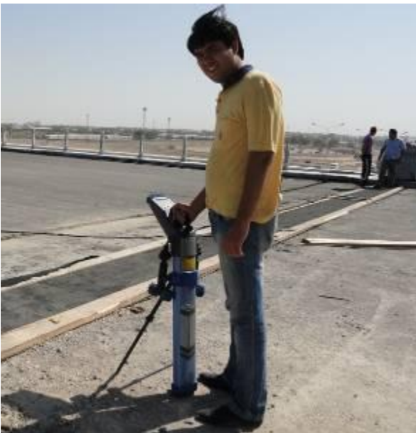
La détection d'un trou pilote.
