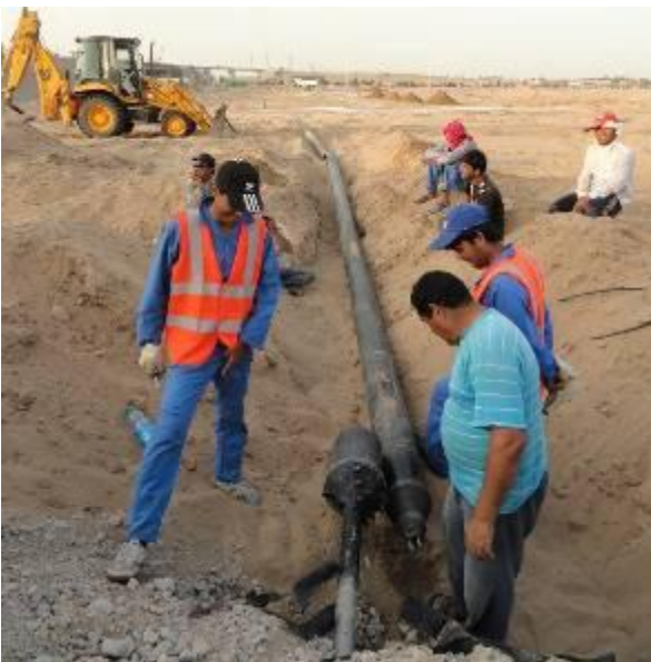
Le tube acier DE 324 mm est relié à l'alésure \varnothing 420 mm. Puis commence l'introduction du tuyau.
