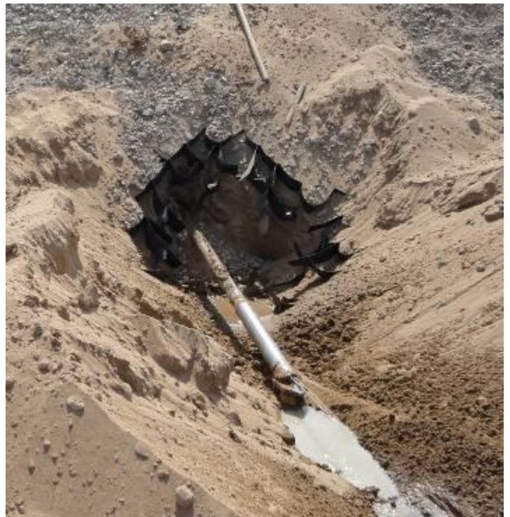
La tête de forage atteint l'autre côté de la route.
