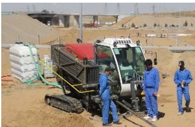
La TERRA-JET 8522 S au forage d'un trou pilote
