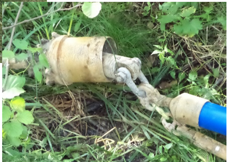
→ L'aléreur ø 260 mm avec les deux fourreaux PEHD DE 110 mm et DE 63 mm juste avant l'introduction des fourreaux.
