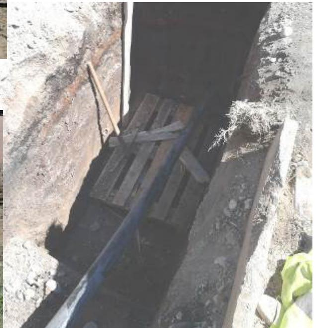
↑ Le tuyau HDPE DE 90 mm a été tracté par le fonceur TERRA.
