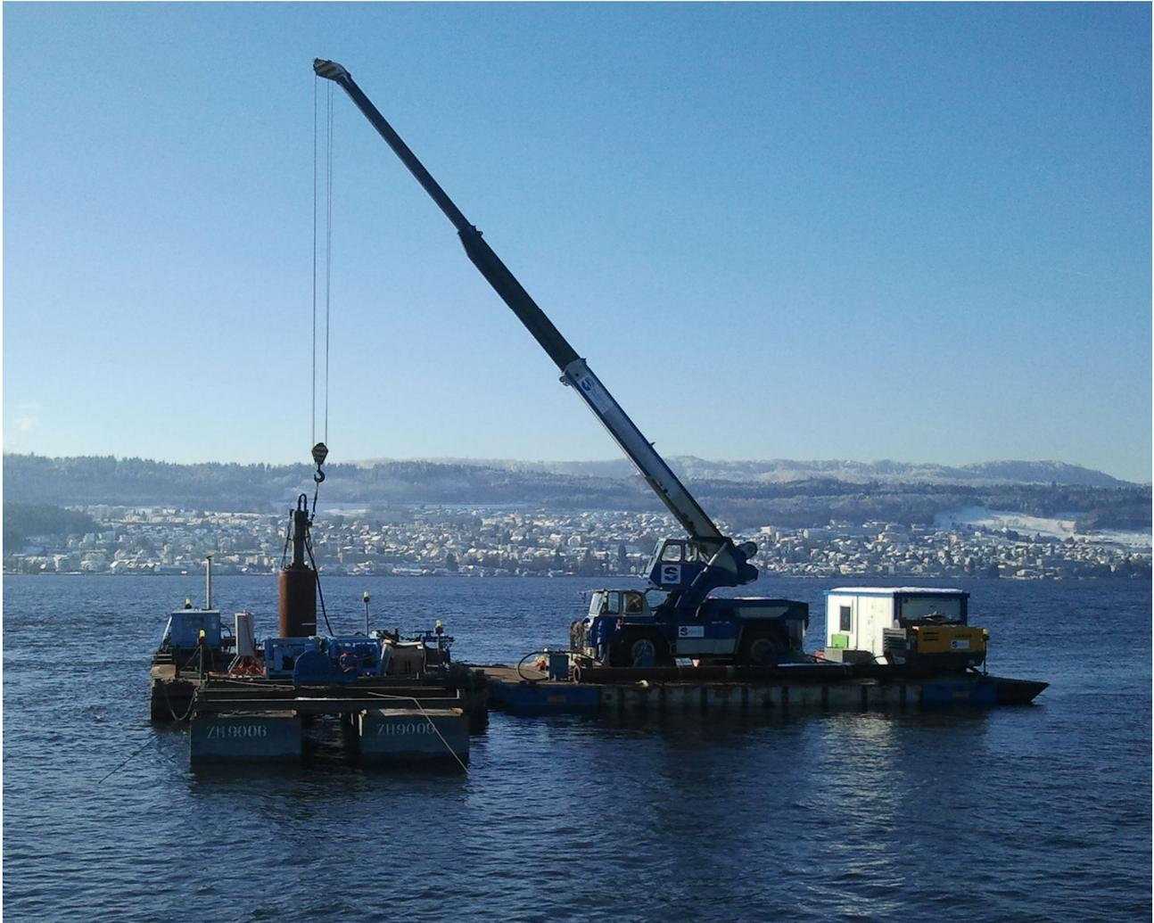
Pour renforcer la ligne déjà en place des pieux d'amarrage du port d'accueil des ferries de Meilen, sur le lac de Zürich, l'entreprise Willy Stäubli Ing. SA, spécialiste en travaux hydrauliques, a battu un tube acier d'un diamètre de 1'000 mm. Différentes pattes de fixation ont d'abord été soudées sur le tube, qui a ensuite été couché sur un ponton pour l'emporter sur le lieu du chantier. Là, le pieu a été mis à la verticale et aligné.
