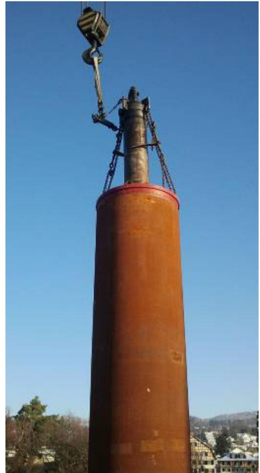
Le pieu en tube acier  $\varnothing$  1'000 mm est enfoncé avec le marteau pousse-tube TERRA TR 360.
