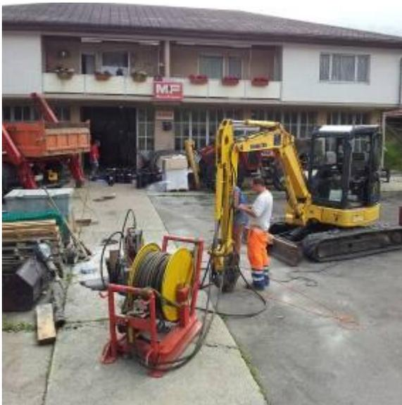
L'éclateur à câble TERRACTOR X 400 est installé dans la fouille d'arrivée. L'entraînement hydraulique et l'alimentation électrique de l'éclateur, ainsi que de l'enrouleur s'est fait par la commande auxiliaire d'une pelle de 5 tonnes.
