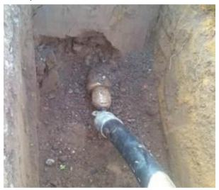
L'introduction s'est faite à l'aide d'un aléseur avec dents au carbure ø 115 mm. Grâce à la transmission de puissance du vérin double, récemment développé par TERRA, le fourreau a pu être introduit facilement dans le terrain dur.
