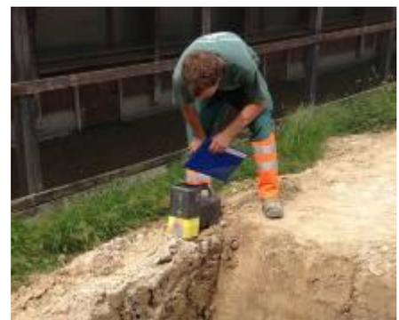
Le tracé de la tête de forage est suivi tout au long du forage du trou pilote à l'aide d'un système de localisation, qui sert également au guidage sur la cible.
