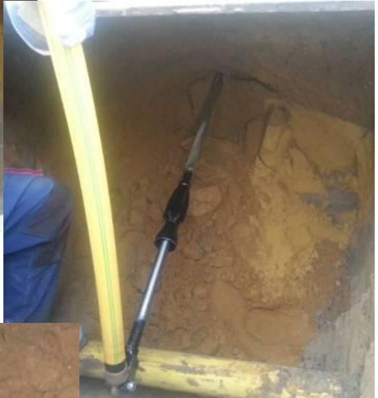
Le fourreau PEHD DE 50 mm est préparé. L'élargisseur étoilé et la cloche d'élargissement  $\varnothing$  75 mm sont raccordés.
