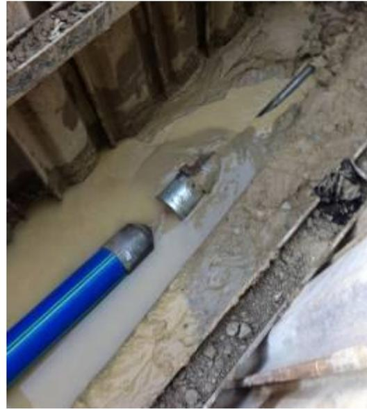
Le trou pilote est terminé. Le sol était argileux et gravillonneux avec des inclusions de pierre. Comme tête de forage, on a utilisé une tête 3 doigts. La tête de forage est démontée, et remplacée par un aléreur.
