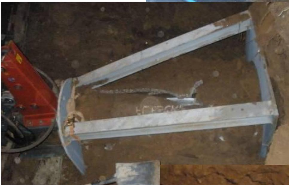
A la fin de l'opération d'éclatement, l'éclateur DE 610 mm est tiré à l'intérieur du cadre avant spécial du X 400.
