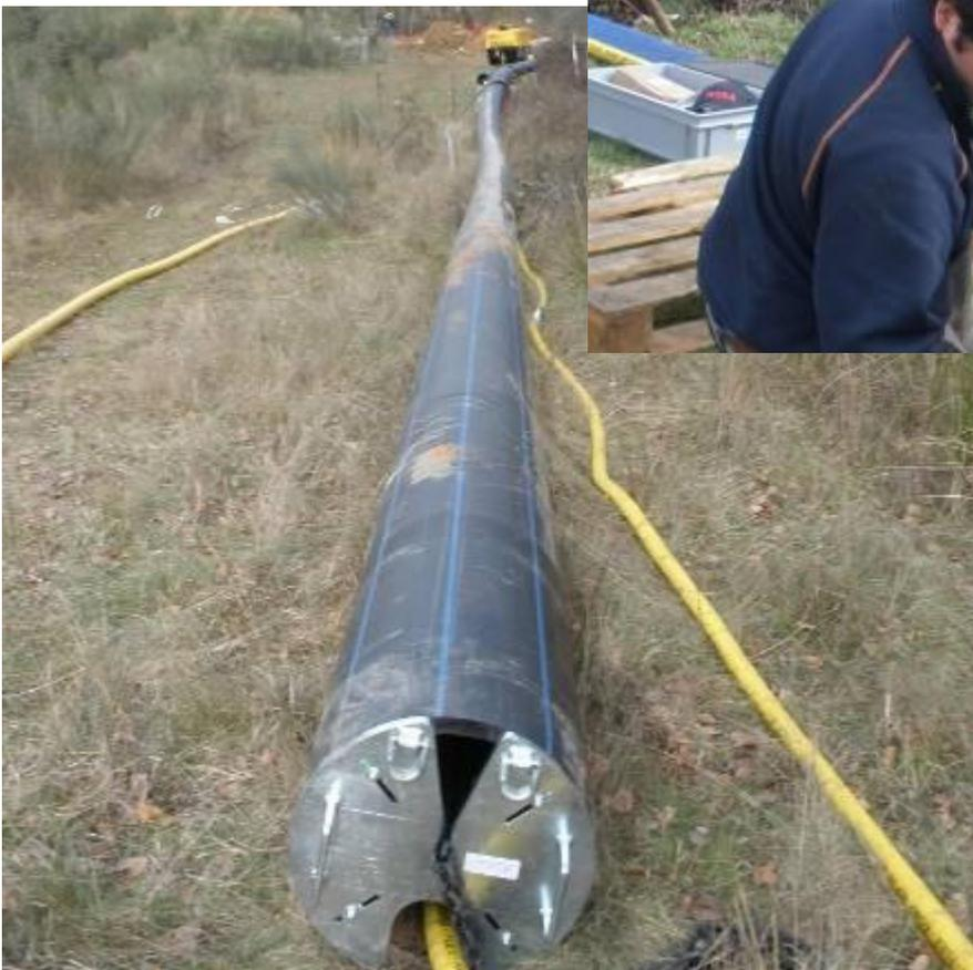
Le nouveau fourreau  $\varnothing$  500 mm de 90 m de long est aligné. La plaque d'appui arrière et la chaîne à l'intérieur, supportent une partie des forces de traction.
