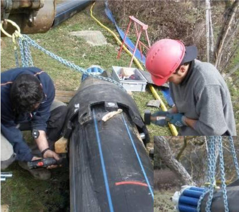
Le fourreau PEHD  $\varnothing$  500 mm est relié à l'élargisseur DE 610 mm par un système de fixation par axes breveté. Les axes sont lisses et ne dépassent pas à l'extérieur.
