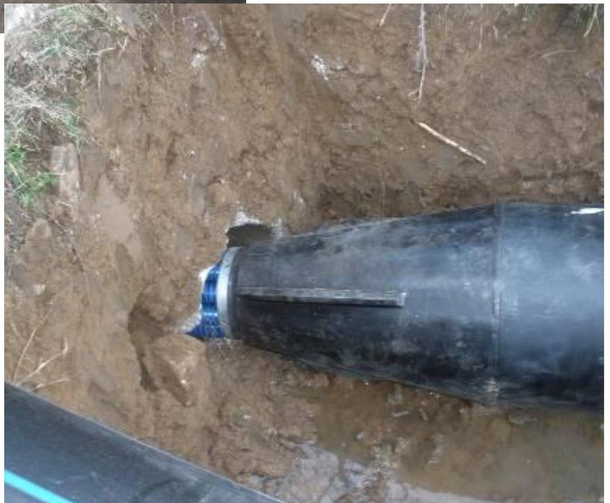
L'élargisseur éclateur dynamique avec à l'intérieur le marteau pousse-tube TERRA TR 220, et le nouveau fourreau PEHD  $\varnothing$  500 mm disparaissent dans la terre.
