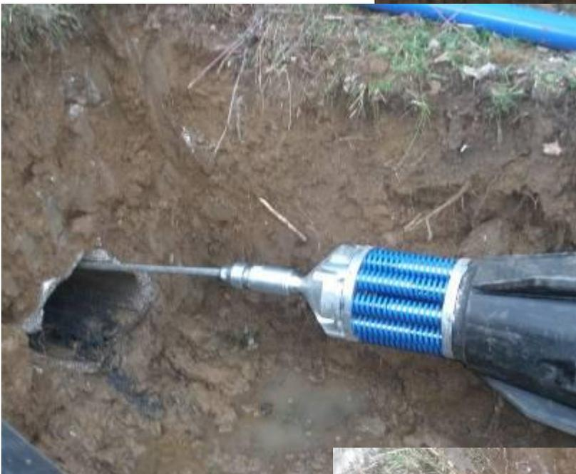
Départ: l'éclateur à câble X 400 tire l'élargisseur DE 610 mm avec le fourreau de 500 mm à l'intérieur de l'ancien tuyau de 400 mm.
