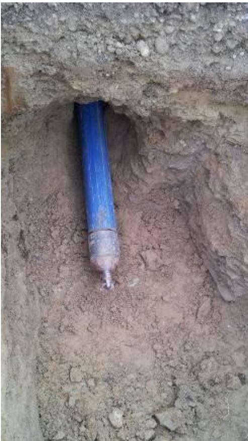
L'opération d'éclatement est terminée avec succès. La pièce de réparation en fonte ductile a été sectionnée avec le couteau à rouleaux et le nouveau fourreau PEHD DE 160 mm introduit. La nouvelle canalisation peut maintenant être raccordée au réseau d'eau potable existant.
