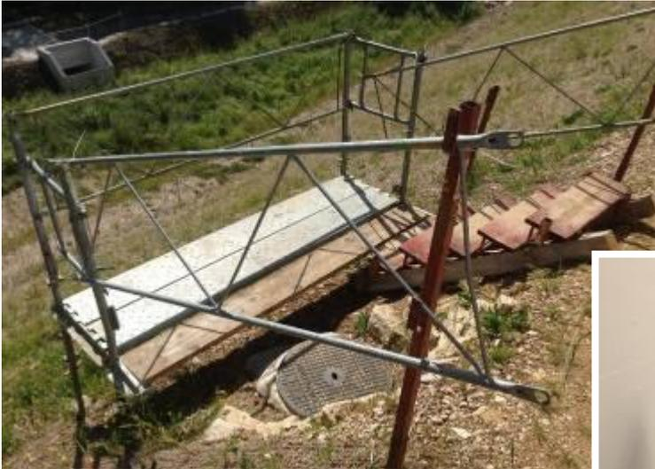
← Une plateforme de travail avec escaliers d'accès a été installée au-dessus du regard d'arrivée. Ce regard de 800 mm est profond de 10 m et a été percé à mi-hauteur.
