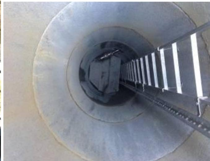
Après la réalisation du trou pilote, un plancher provisoire a été mis en place dans le regard.
