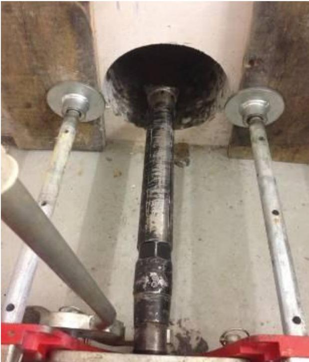
L'installation de la foreuse est terminée, et le porte-sonde avec la tête directionnelle sont montés.
