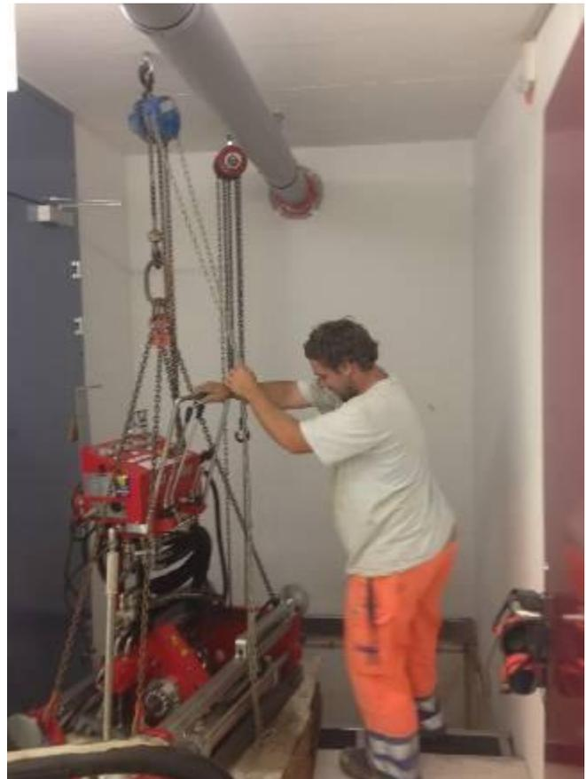
La foreuse est mise en position de forage à l'aide de palans à chaînes.
