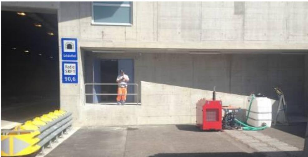
Le groupe hydraulique, la station de mélange et la cuve de fluide ont été installés à l'entrée du tunnel.
