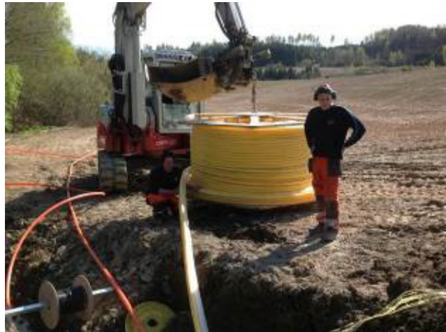
Les fourreaux à poser sont sur un touret accroché à la pelle, prêts pour l'opération d'alésage et d'introduction simultanée.
