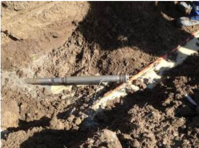
Le forage du trou pilote a atteint avec précision la conduite principale dans la fouille d'arrivée. Le forage a été réalisé avec une tête de forage trois
