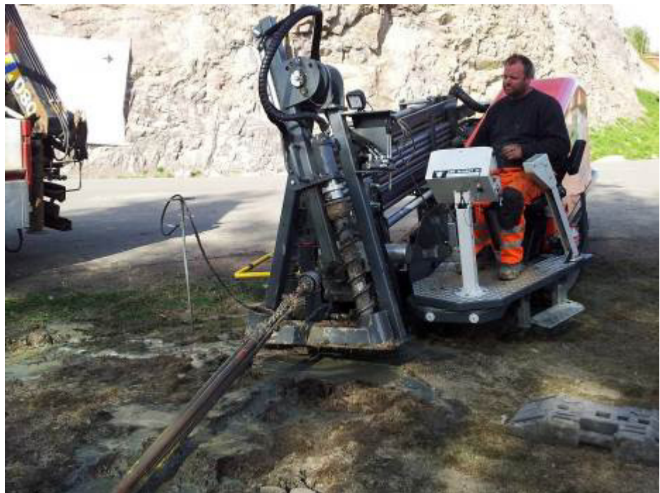
Le maître-foreur et propriétaire Henrik Mikkelsen tire les fourreaux plus en arrière en reculant la machine, après un alésage rapide et sans problème avec introduction simultanée.
