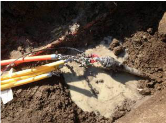
Le forage du trou pilote a atteint avec précision la conduite principale dans la fouille d'arrivée. Le forage a été réalisé avec une tête de forage trois
