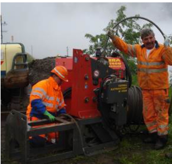
Le câble de traction est introduit dans l'éclateur à câble et ensuite dans l'ancien tuyau.
