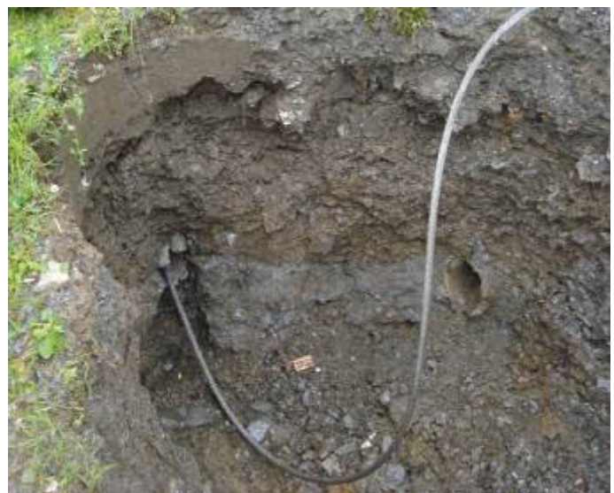
Le câble de traction est introduit dans l'éclateur à câble et ensuite dans l'ancien tuyau.
