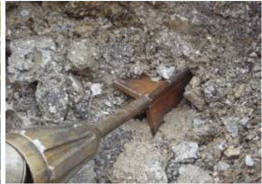
Le couteau éclateur découpe l'ancien tuyau béton.
