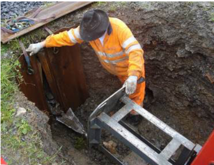
Le couteau éclateur arrive dans la fouille de tirage.
