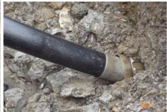
Le cône élargisseur repousse le matériau de l'ancien tuyau sur le côté, et crée un canal pour le nouveau tuyau.
