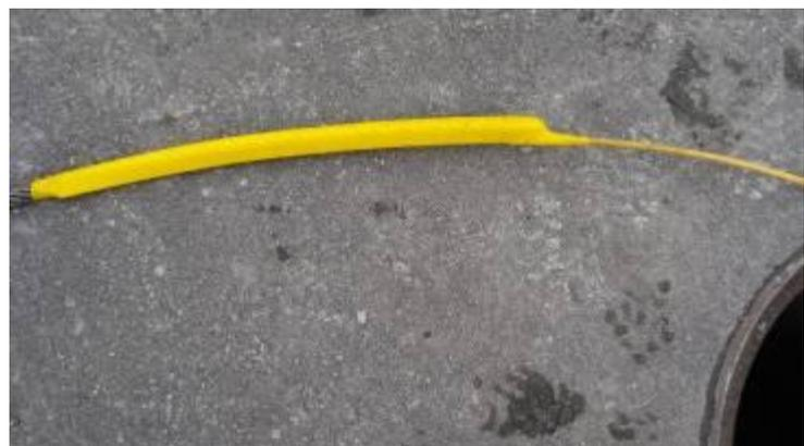
Le câble de traction de  $\varnothing$  22 mm est attaché à l'aiguille de tirage et tiré ainsi dans l'ancienne canalisation.
