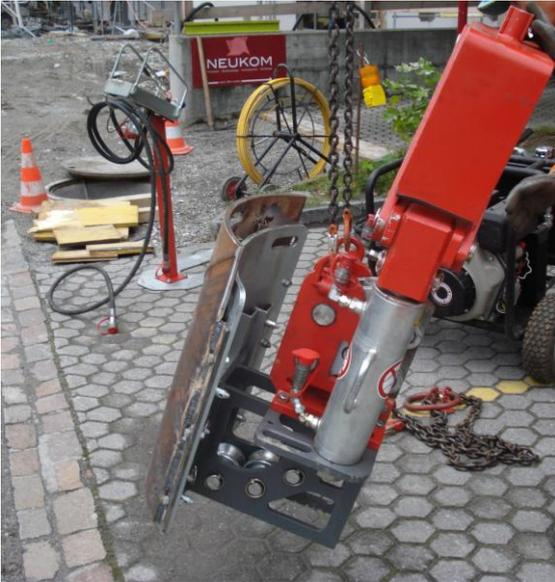
L'éclateur à câble X 300 C avec sa plaque d'appui courbe est installé dans le regard ø 800 mm.
