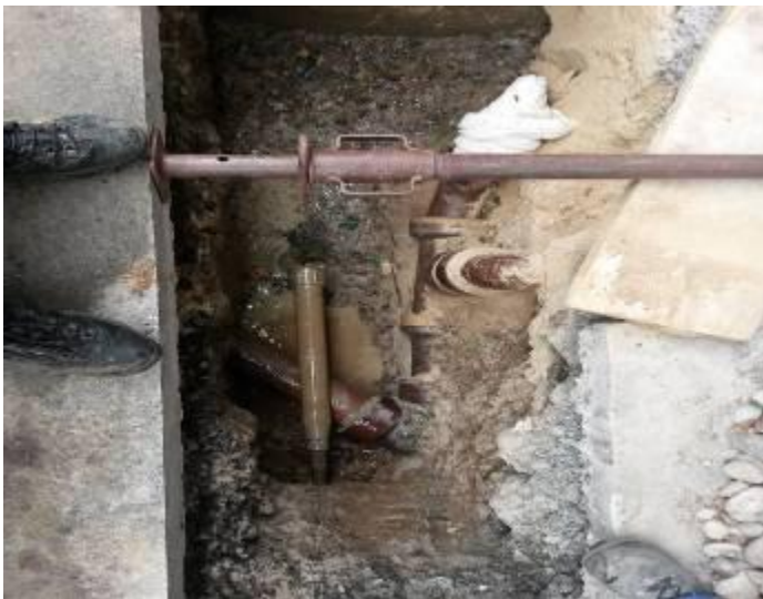
Vue du dessus de la fouille d'arrivée. On voit nettement l'alignement parallèle avec les conduites en grès existantes.
