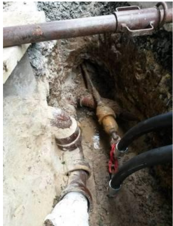
Le faisceau de fourreaux raccordé à l'alésur, avant l'introduction.
