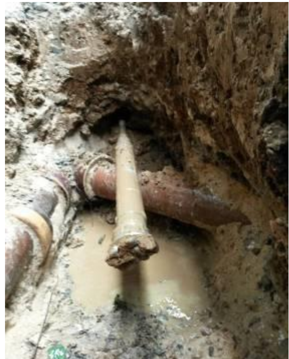
La tête de forage atteint sa cible avec une précision millimétrique. La tête 3 doigts montée a été choisie auparavant, pour pouvoir forer dans des terrains durs et de la roche friable.
