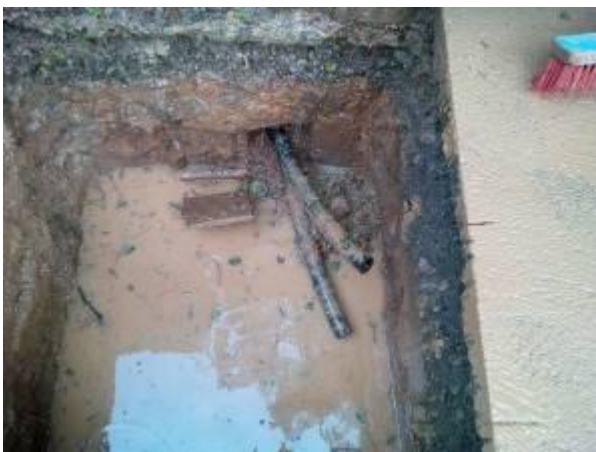
Les 2 fourreaux de protection DE 63 mm après l'introduction.
