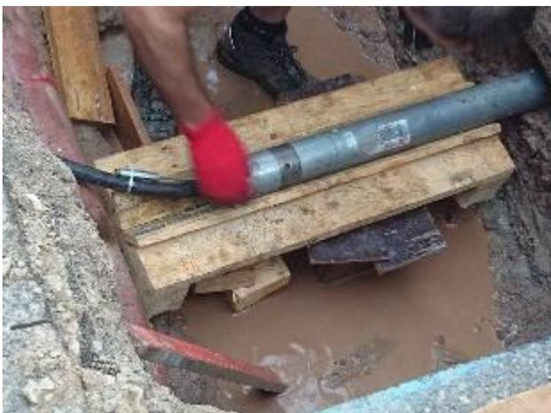
Le fonceur TERRA T 080mini SK dans la petite fouille de départ lors de la pénétration dans le sol.
