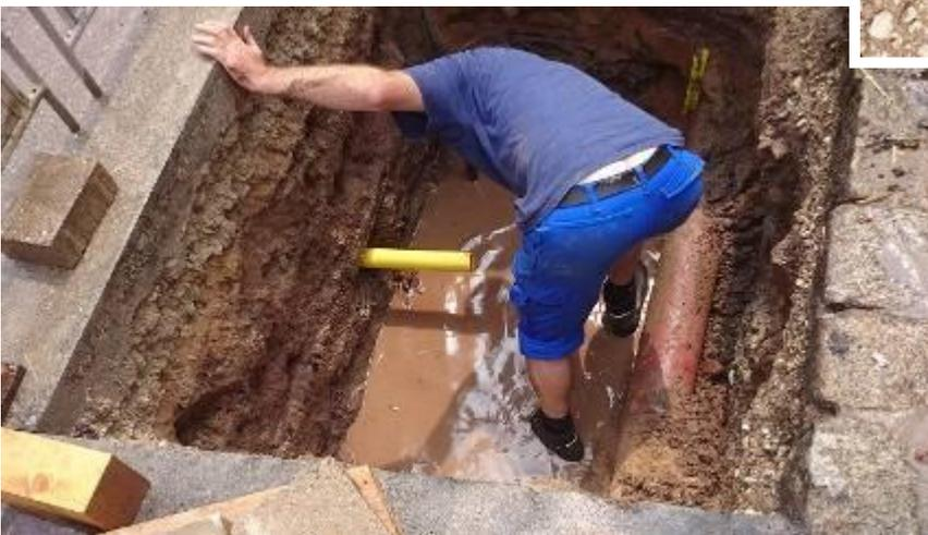
Le fourreau de protection est posé jusqu'à la fouille d'arrivée. ↑
