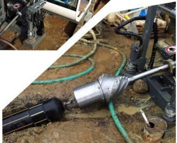
En raison de la dureté du terrain, il a fallu réaliser trois alésages intermédiaires. Après les alésages intermédiaires à 215 mm, 300 mm et 360 mm, le tuyau a été introduit avec succès, en l'espace de trois heures à l'aide de l'aléseeur 360 mm.
