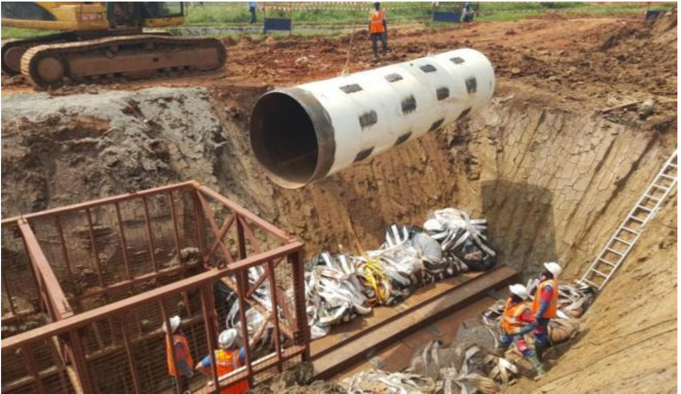
Pic. 3: Le premier tube acier \varnothing 1 500 mm est descendu dans la fouille.
