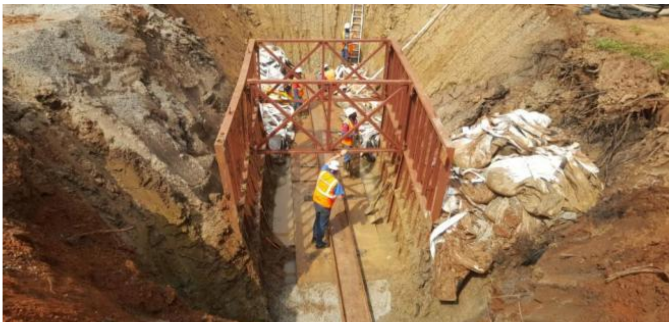
Pic. 2: Préparation de la fouille de travail avec l'installation d'un rail qui guidera les tubes acier avec la pente nécessaire.
