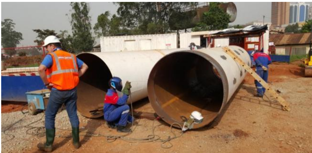
Pic. 1: Préparation de la trousse coupante du premier tube acier \varnothing 1 500 mm. Cette dernière permet de renforcer le 'nez' du tube pour qu'il poinçonne avec facilité le terrain glaiseux et humide de Kampala la capitale.
