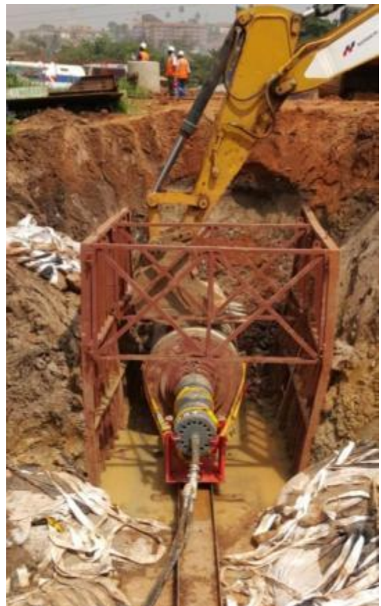
Pic. 5: Frappe et insertion du tube acier. Le godet de la pelle maintient le tube acier lors des premiers mètres.
