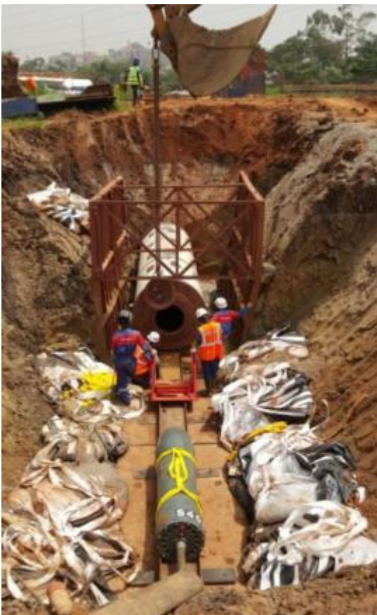
Pic. 4: Les anneaux et le TR 565 sont ensuite montés.
