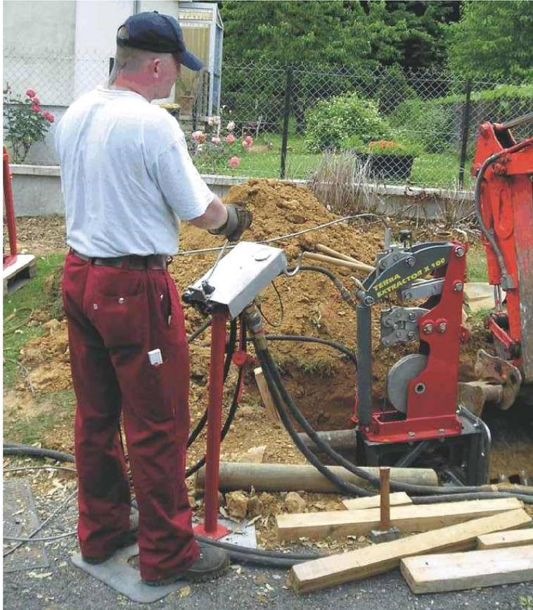
Le TERRACTOR X 100 dans sa fouille de départ. L'opérateur se tient à côté de la fouille et manœuvre la machine depuis un pupitre de commande.
