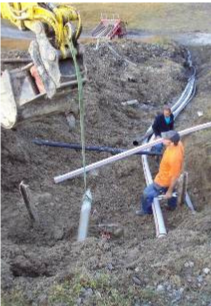
Le fonceur TERRA avec l'élargisseur et le fourreau attaché atteint la fouille d'arrivée.
