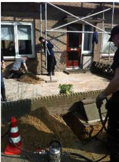
← Le fonceur TERRA T 055 SK atteint la fouille d'arrivée en 5 minutes.
