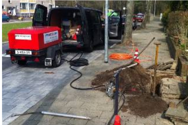
← Vue sur la fouille de départ et le compresseur
