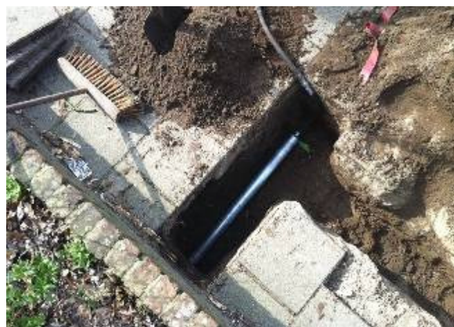
Le fonceur TERRA-HAMMER T 055 SK commence à rentrer dans le sol.
