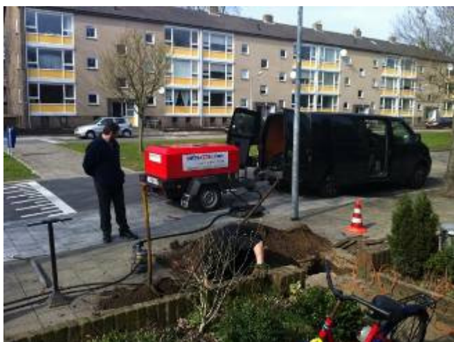
La fouille de départ est préparée.
