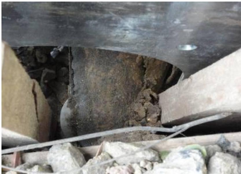
On voit bien ici comment le couteau à rouleaux atteint la fouille d'arrivée. A la fin de l'éclatement, les outils d'éclatement atteignent la plaque d'appui du TERRACTOR X 400 et peuvent être démontés en quelques simples manipulations.
