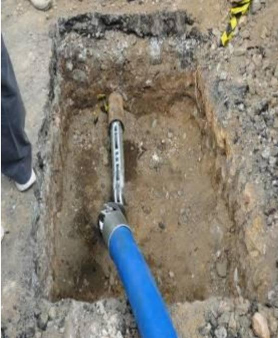
On voit bien ici comment l'élargisseur  $\varnothing$  135 mm repousse sur le côté l'ancien tuyau découpé. Cela crée un solide canal de forage élargi.
