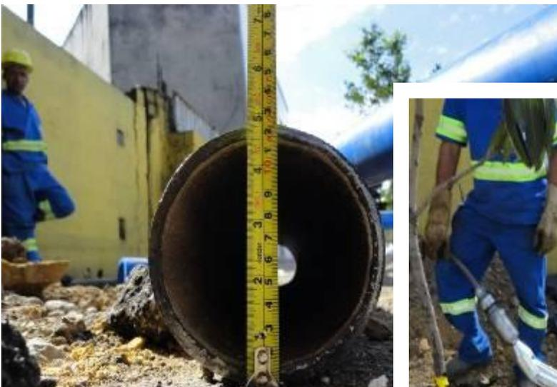
Ce tuyau en fonte ductile de DE 125 mm avec une épaisseur de paroi de 8 mm doit être découpé par le X 400.
