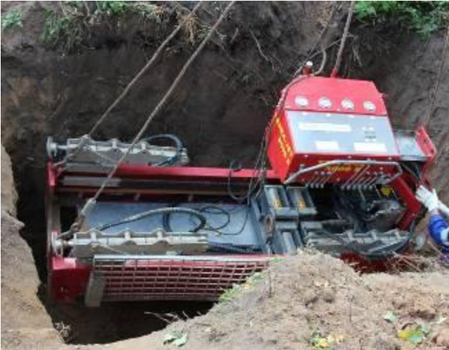
La TERRA-JET 3008 E est installée dans la fouille de départ.
