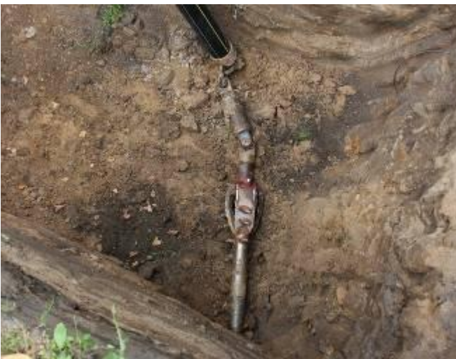
L'aléreur et le nouveau tuyau sont montés. L'aléreur est une conception exclusive de BurMontazh.
