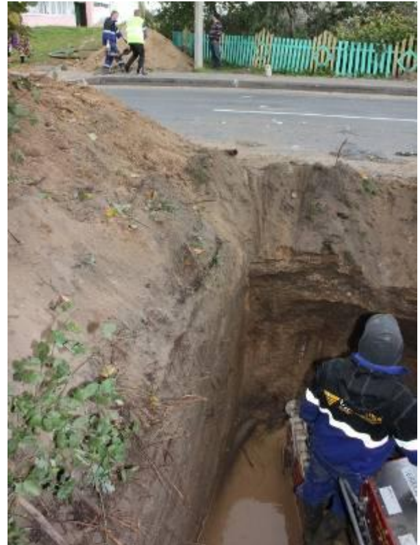
Vue sur un croisement de chaussée typique.
