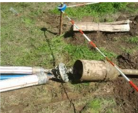
L'aléreur \varnothing 360 mm avec le faisceau de fourreaux (1x DE 132 mm, 1x DE 92 mm, 1x DE 63mm)
