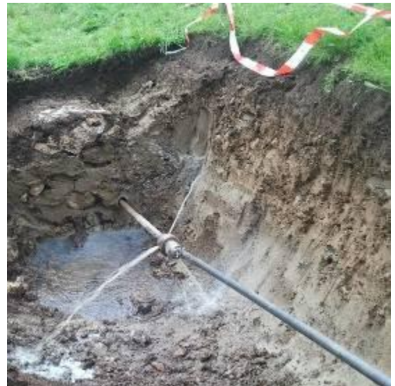
L'alésage intermédiaire à \varnothing 215 mm débute.
