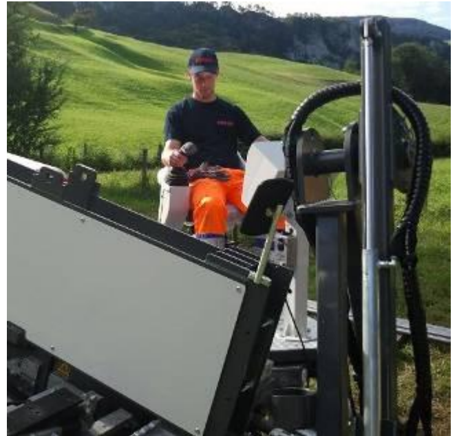
L'opérateur se concentre sur le forage du trou pilote.
