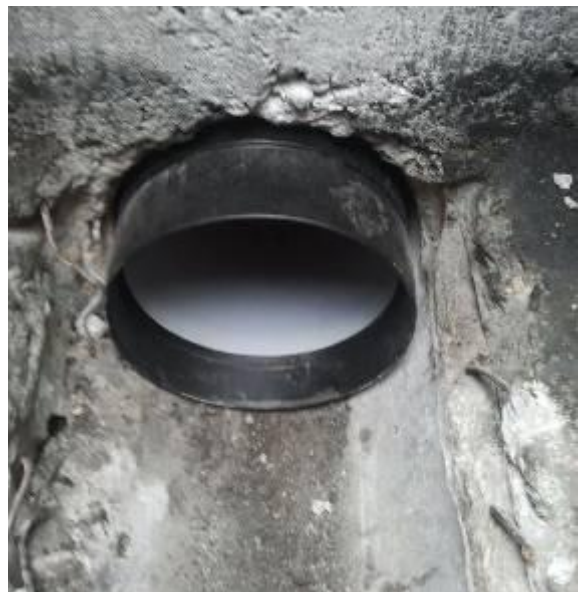
Le nouveau tronçon de tuyaux est posé.
