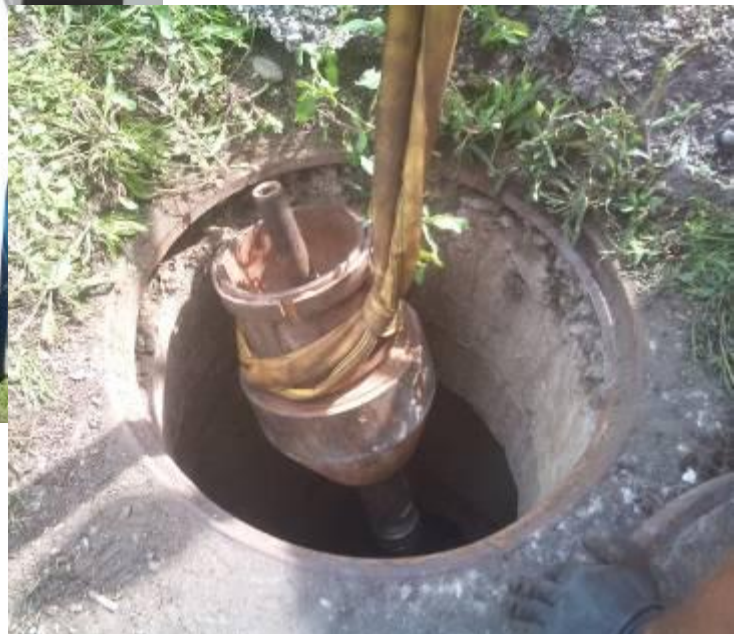
La tête de calibrage \varnothing 295 mm est descendue dans le second regard.
