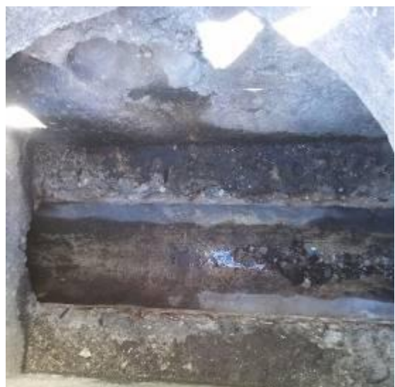
Vue de l'ancien tuyau dans le regard.
