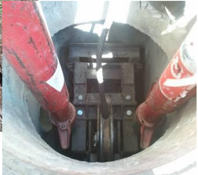
Le cadre de regard est mis en place dans le regard \varnothing 800 mm.
