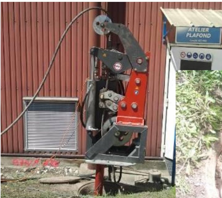
L'éclateur à câble TERRACTOR X 400 est monté sur deux bras de force au-dessus de la bouche du regard.
