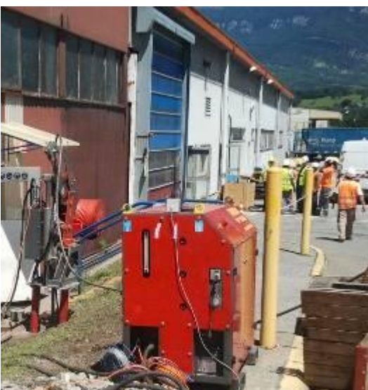
Vue sur l'un des tronçons à renouveler.
