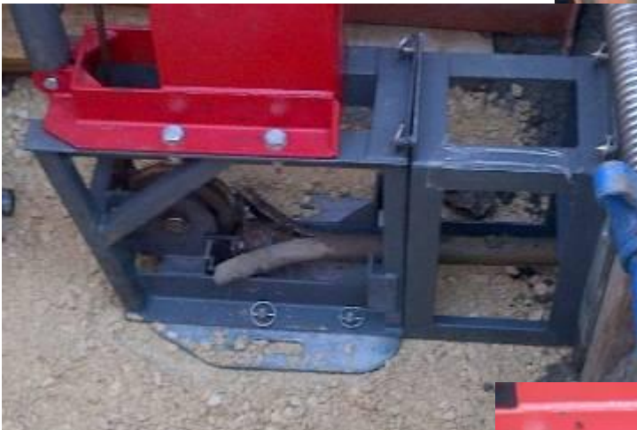
← L'ancien tuyau est expulsé et découpé par le cône découpeur.
