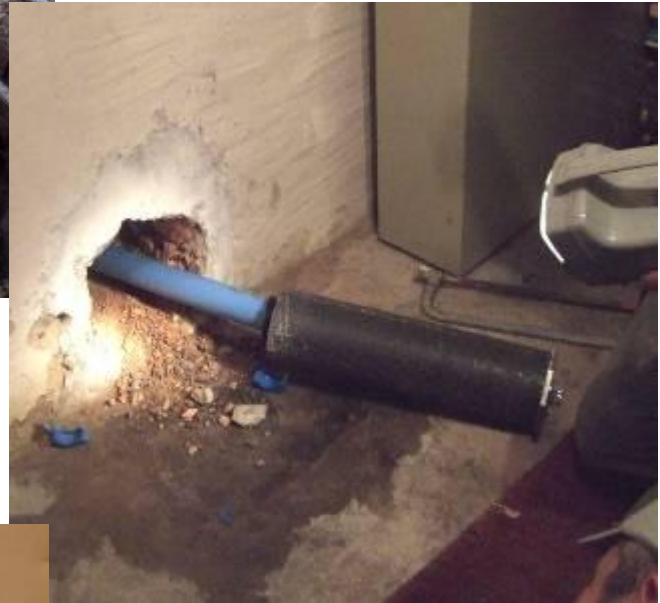
→ L'étanchéité du passage du mur.
