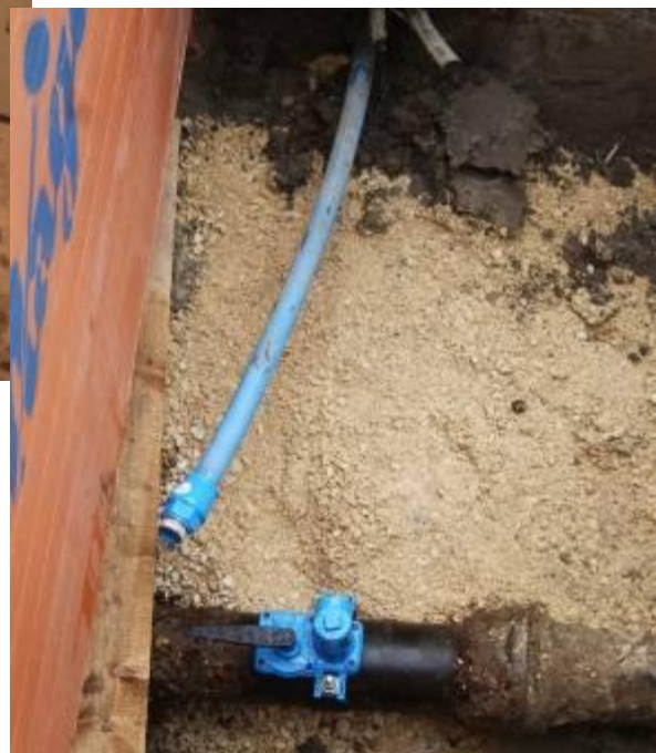
→ La nouvelle canalisation est raccordée à la conduite principale.
