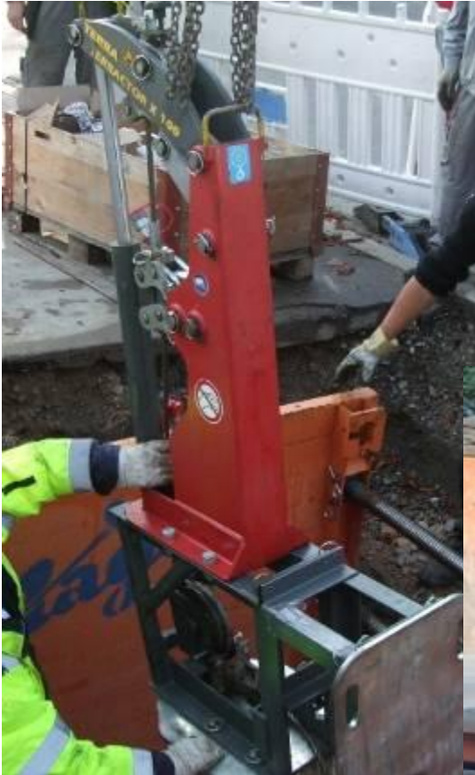
→ L'éclateur à câble X 100 est raccordé à l'hydraulique d'une mini-pelle.
