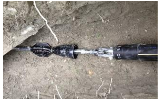
L'alésage final au \varnothing 110 mm commence. Le fourreau PEHD \varnothing 90 mm est introduit simultanément.
