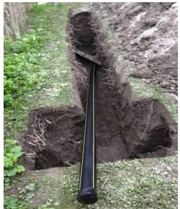
→ Du côté de la fouille d'arrivée, le tuyau introduit est raccordé à la canalisation principale.
