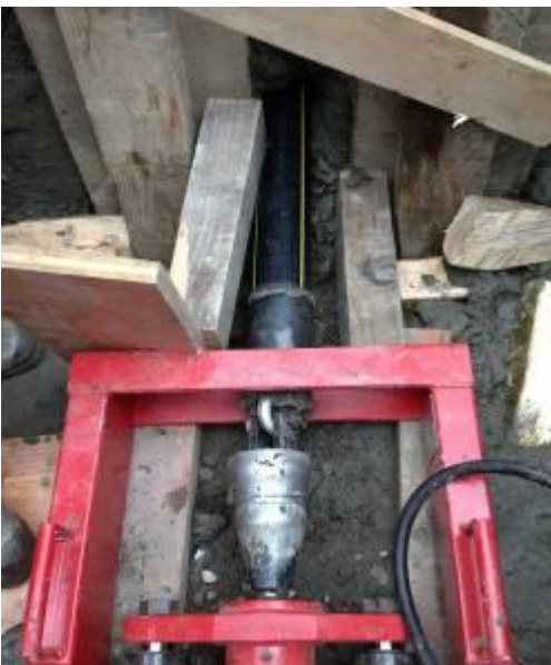
L'alésage intermédiaire est terminé. L'étoile cisailante arrive dans la fouille.
