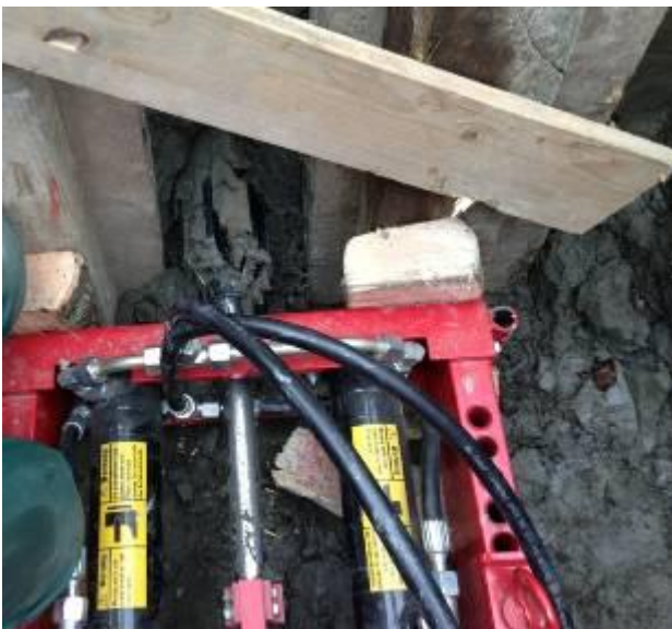
L'alésage intermédiaire est terminé. L'étoile cisailante arrive dans la fouille.
