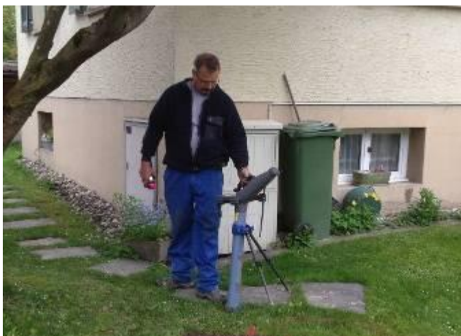
La tête de forage est suivie à l'aide du détecteur.
