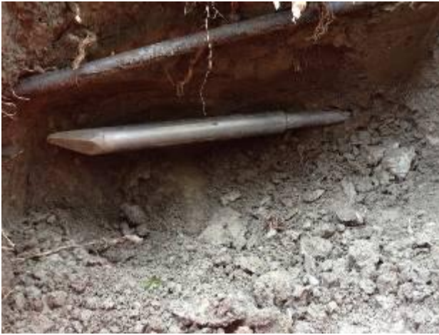
Après 22 m, la tête de fonçage atteint la fouille d'arrivée.
