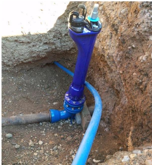
Le canal de forage est élargi pendant l'introduction du fourreau avec une cloche élargisseuse de  $\varnothing$  75 mm et le nouveau fourreau PEHD DE 50 mm est introduit simultanément. Le raccordement à la canalisation d'eau principale est préparé.
