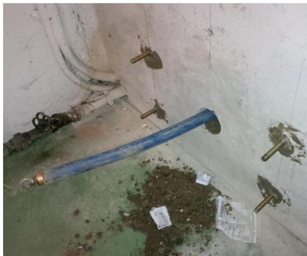
Après l'introduction du fourreau, la TERRA-JACK est démontée. Elle peut facilement être transportée par deux personnes. La conduite d'eau est raccordée dans la maison.
