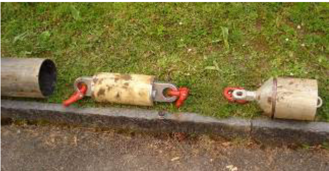
L'appareil de mesure de forces de traction est monté entre l'élargisseur et le mandrin. La douille de protection, visible à côté, protège l'appareil de mesure contre les éventuels dommages dus à des tessons de l'ancien tuyau.
