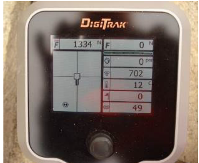
L'écran du détecteur indique la force de traction. Ces données sont également retransmises à un moniteur qui informe en temps réel l'opérateur de l'éclateur à câble, de la force de traction sur le nouveau fourreau.
