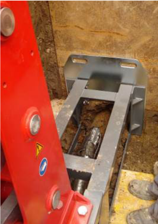
Le couteau à rouleau arrive dans la fouille de traction.
