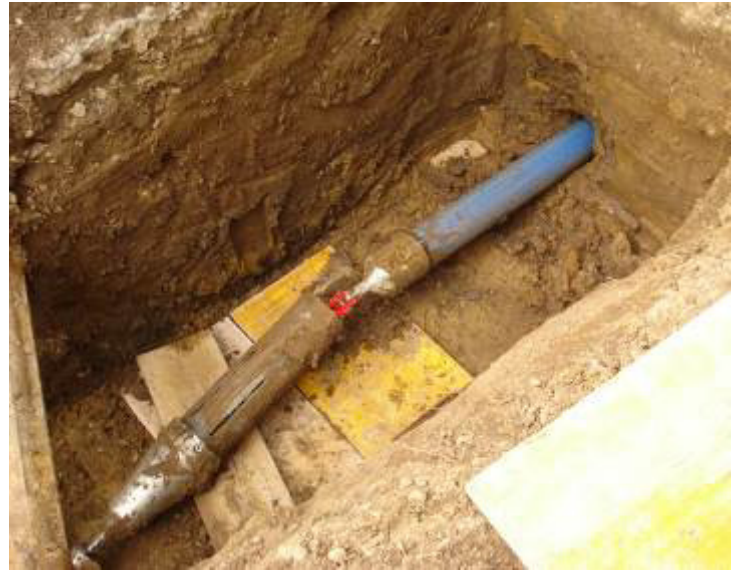
L'éclateur à câble a été déplacé dans la fouille de tirage de sorte à ce que l'élargisseur et le fourreau de protection puissent être démontés. Le fourreau avec gaine protectrice peut maintenant être raccordé au réseau de canalisation d'eau potable existant.
