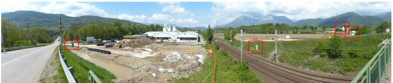
SOGEA 38 a eu en charge d'effectuer plusieurs fonçages de Ø 400 mm et Ø 600 mm sous l'autoroute A41 et une bretelle d'accès (AREA), sous la double voie de train (RFF-SNCF) reliant GRENOBLE à CHAMBÉRY et une piste cyclable ainsi que sous l'accès routier d'une entreprise.
