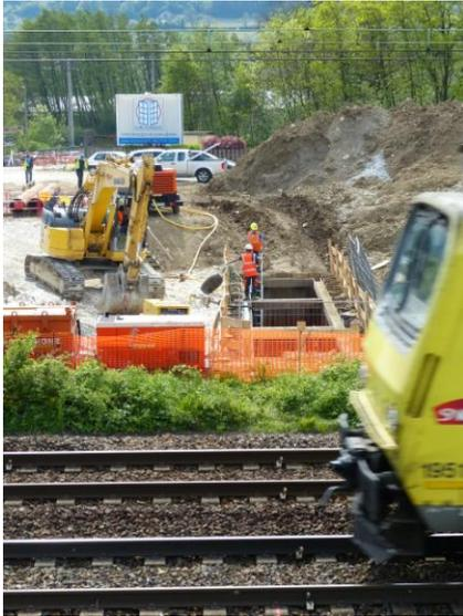
Les 52 mètres de fonçage en Ø 600 mm sous la voie ferrée et la piste cyclable ont été réalisés sans aucun curage intermédiaire et avec des vitesses d'avancement allant de + 35 m/h à 12 m/h sur les derniers mètres.
