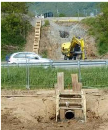
A gauche: Les 39m de fonçage en Ø 600 mm sous l'autoroute.
