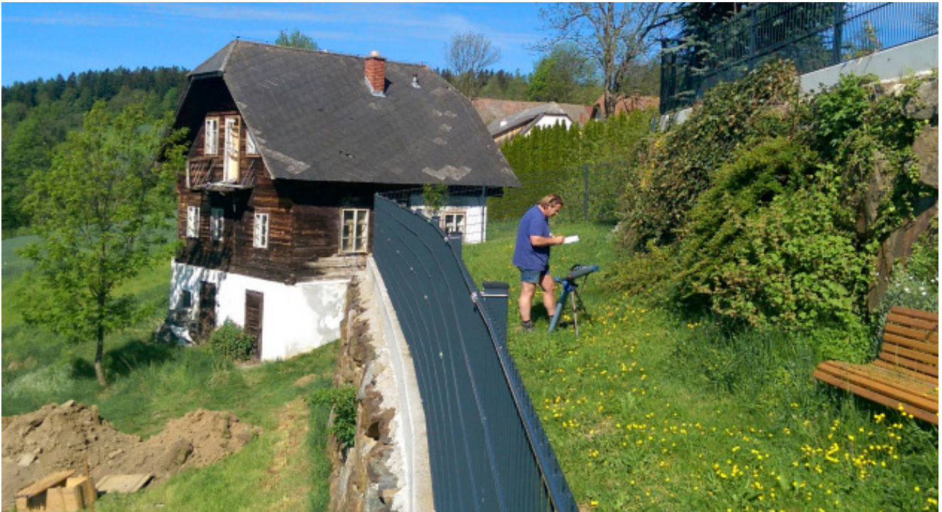
Image 2: Le tir pilote est en cours et il est suivi avec grande précision grâce au système de détection. Les murs en pierre et les clôtures ont légèrement gêné la détection. Mais en gardant un œil sur le tracé du tir pilote à chaque tige de forage, la fouille d'arrivée a été atteinte avec précision.
