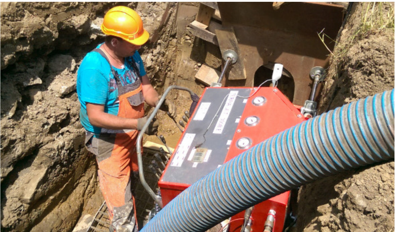
Image 3: Le foreur Jürgen Ertl manœuvre la TERRA-JET TJ 3008 ES. Les vérins de calage permettent un calage rapide, facile, ferme et sûr de la machine dans la fouille. La Bentonite accumulée a été aspirée par une aspiratrice placée à proximité.
