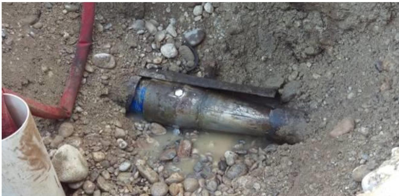
Le cône élargisseur et la nouvelle canalisation sont tirés à travers une fouille intermédiaire.
