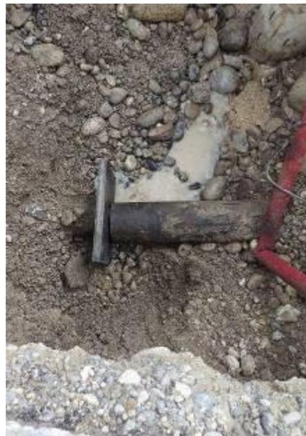
Lors d'une fouille intermédiaire d'un branchement, la vanne a été déposée au préalable. Cette 'plaque d'arrêt' évite que l'ancienne canalisation glisse de trop et vienne se télescoper dans l'autre partie.
