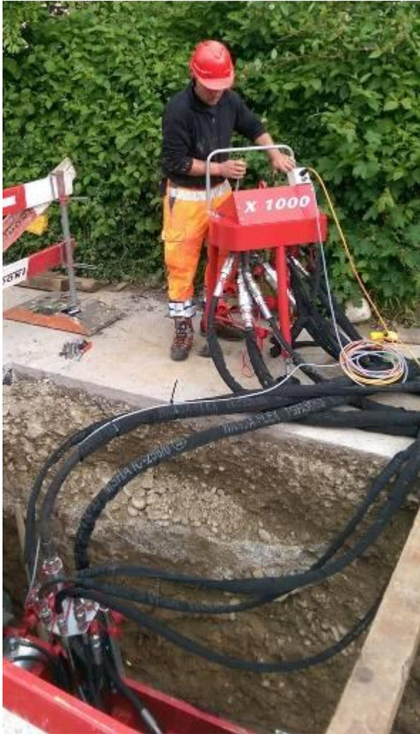
Le pupitre de commande déporté permet d'actionner la machine depuis la surface. Ainsi, pendant que la machine travaille, les opérateurs ne restent pas dans la fouille.
